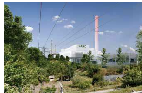
Metodou Design&Build se nyní vybírá například zhotovitel nové spalovny SAKO Brno, která má zpracovávat 132 000 tun odpadu, který dosud končí na skládce. Metoda Design&Build byla zvolena s ohledem na vysoký až 70% podíl specifické technologie na hodnotě celé zakázky. Zadávacím podkladem bylo platné územní rozhodnutí z 18. 9. 2021 a dokumentace pro územní rozhodnutí, kterou zpracovala Tenza, a.s. Nyní je výběrové řízení ve stavu zpracování předběžných nabídek. Uvedení do provozu se očekává koncem roku 2025. Využití odpadní energie ve výši až 104,1 % zařadí zdroj mezi nejúčinnější kombinované zdroje výroby elektrické energie a tepla v rámci celé ČR a zvýší podíl CO2 neutrální elektrické energie o 119 GWh na celkem 190 GWh. Toto množství představuje 46 % z dosavadní celkové výroby elektrické energie na území města Brna.
