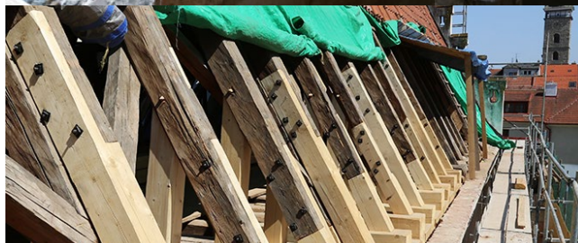
Silně poničený historický krov Solnice v Českých Budějovicích se podařilo úspěšně opravit.
