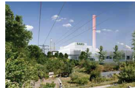
Metodou Design&Build se nyní vybírá například zhotovitel nové spalovny SAKO Brno, která má zpracovávat 132 000 tun odpadu, který dosud končí na skládce. Metoda Design&Build byla zvolena s ohledem na vysoký až 70% podíl specifické technologie na hodnotě celé zakázky. Zadávacím podkladem bylo platné územní rozhodnutí z 18. 9. 2021 a dokumentace pro územní rozhodnutí, kterou zpracovala Tenza, a.s. Nyní je výběrové řízení ve stavu zpracování předběžných nabídek. Uvedení do provozu se očekává koncem roku 2025. Využití odpadní energie ve výši až 104,1 % zařadí zdroj mezi nejúčinnější kombinované zdroje výroby elektrické energie a tepla v rámci celé ČR a zvýší podíl CO2 neutrální elektrické energie o 119 GWh na celkem 190 GWh. Toto množství představuje 46 % z dosavadní celkové výroby elektrické energie na území města Brna.
