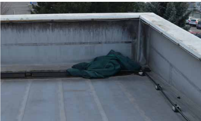
▲ Obr. 15 Ucpané odtoky vody
